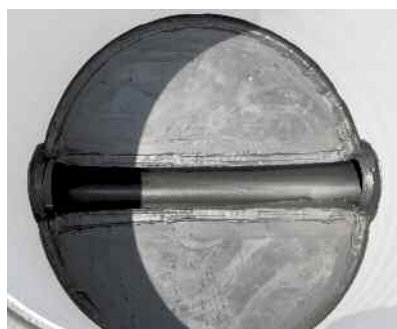
Фото 2. Вид прямопроходного лотка сверху.
