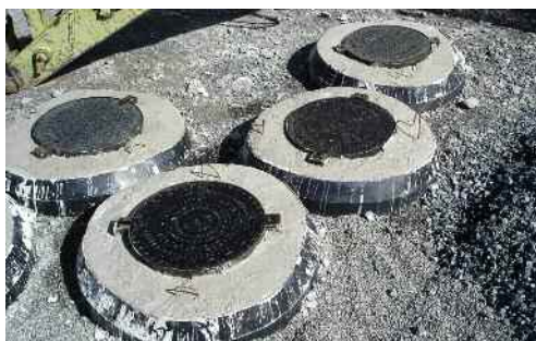
Фото 21. Пример использования формы для бетонирования.
