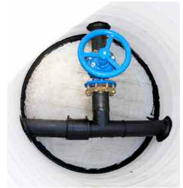
Фото 11. Вид инспекционной камеры сверху.
