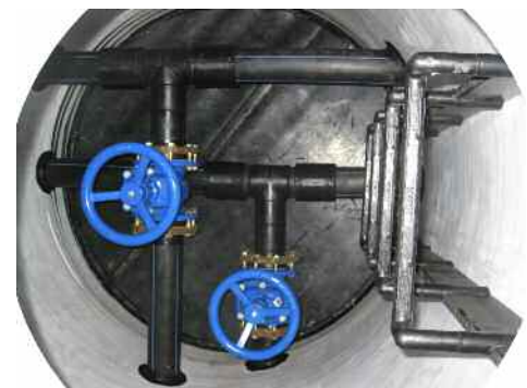
Фото 12. Вид инспекционной камеры сверху.
